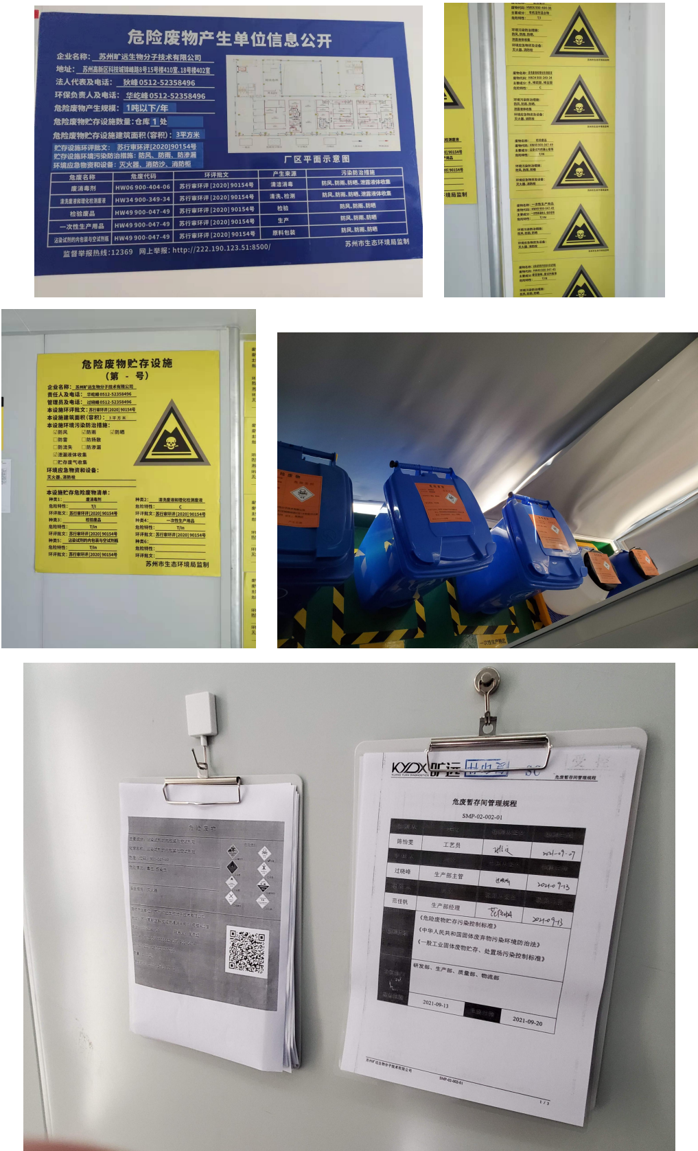
图 3.3 危废仓库实际建设情况
