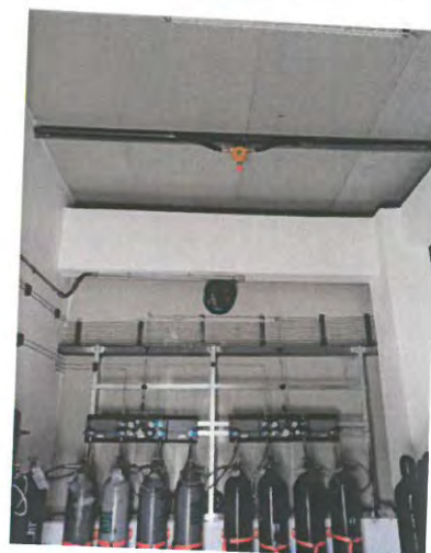
甲类仓库内部
